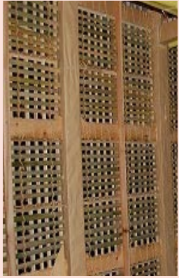
貫と竹小舞による壁 (シア変形性能)
