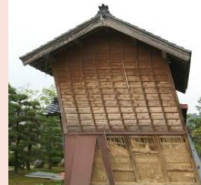
基準法で定める層間変位角層間変位角より傾いてはいるが、倒壊しない。
