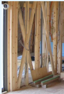
スジカイによる壁 (三角形不変の定理)
