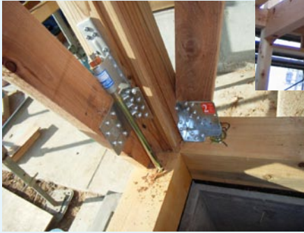
ホールダウン金物で基礎と緊結 N値計算をしてもなかなか外せない
